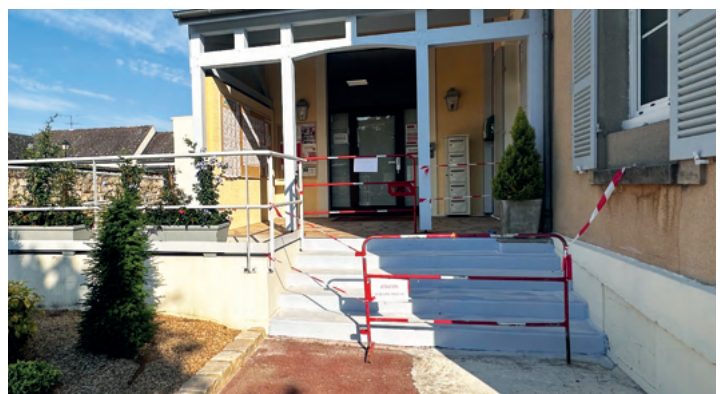
Rénovation de la peinture des marches de la mairie par les agents des Services techniques
